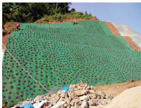
Khi vừa thi công xong
