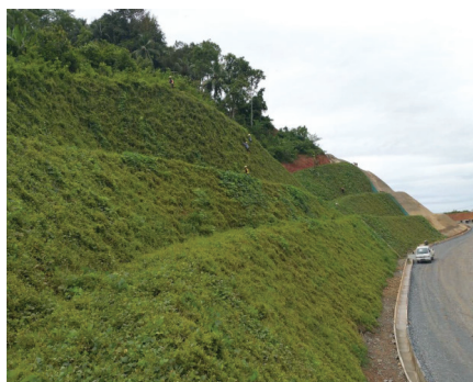
Sau 5 tháng thi công
