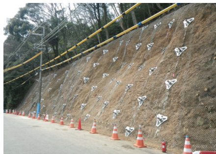
Khi vừa thi công xong
