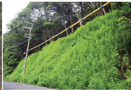
Sau 4 tháng thi công
