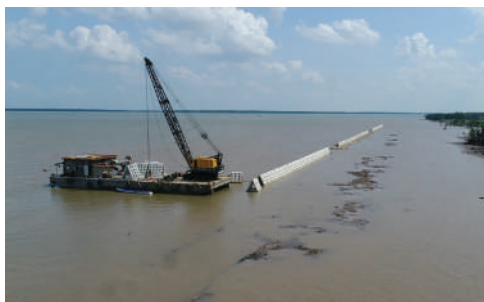
Quá trình vận chuyển và thi công đê giảm sóng kết cấu rỗng.
